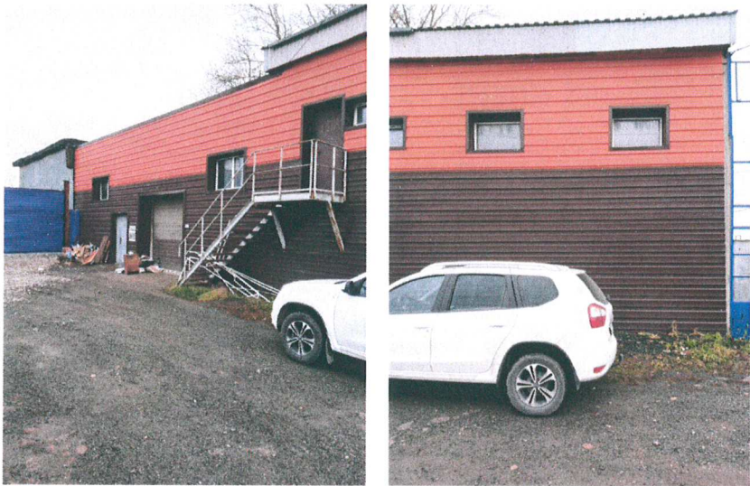
Существующее состояние главного фасада (фотофиксация),
